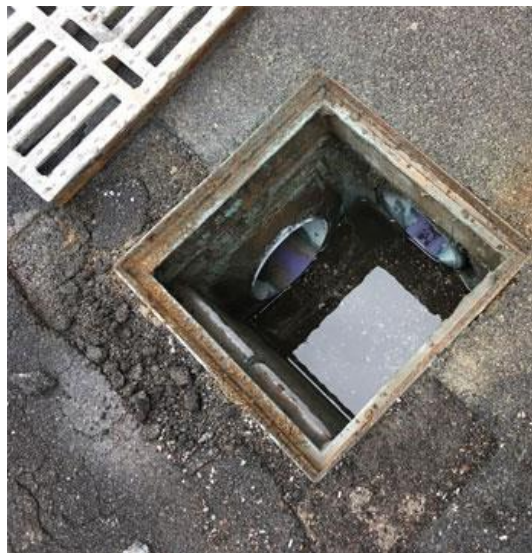
Figura 5 Pozzetti di ispezione
